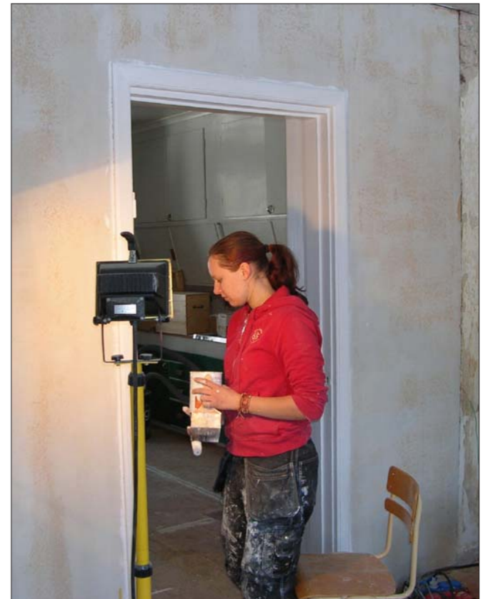
En av eleverna i full färd med att renovera den lägenhet i kasernen Norden som ska spegla 1970-tal.
