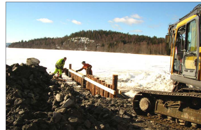
Pålningen i full gång, våren 2005. När pålningen är klar har byborna många ideella timmar framför sig här på den blivande kajen.
