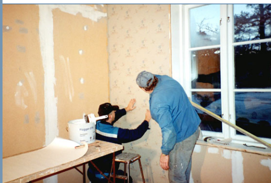
Här pågår tapetsering av kammaren i 1940-talslägenheten. En vacker tidens tapet kommer att pryda rummet.
