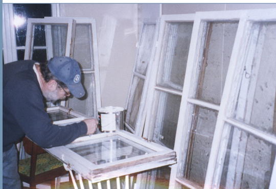
Många är de fönster som är i behov av renovering på Norden. Här jobbar Arne Deniksson med att måla några av dem.
