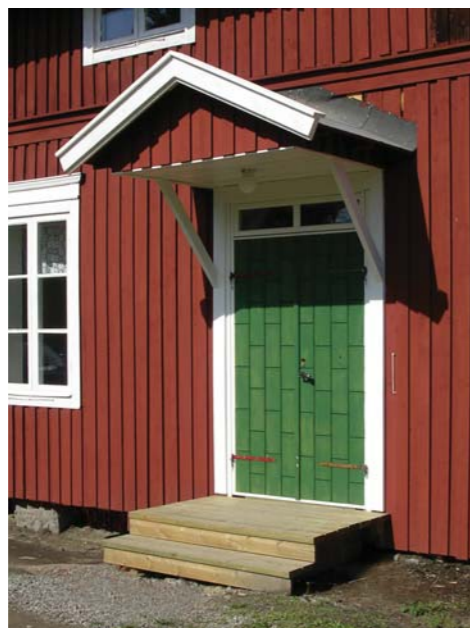
En av entréerna till Norden, med en nytillverkad dörr, där en gammal dörr från bruket varit mall.
